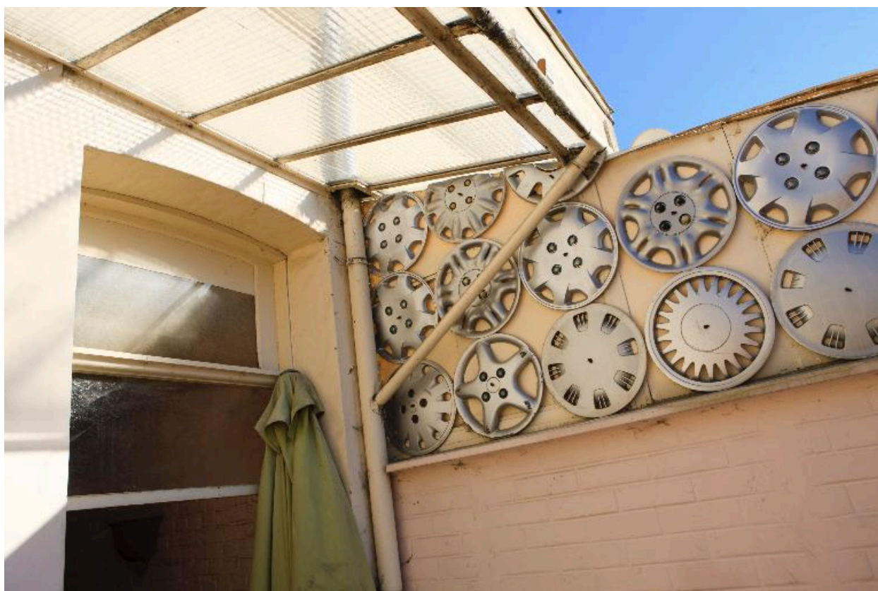
Mur de la véranda, enjoliveurs.
