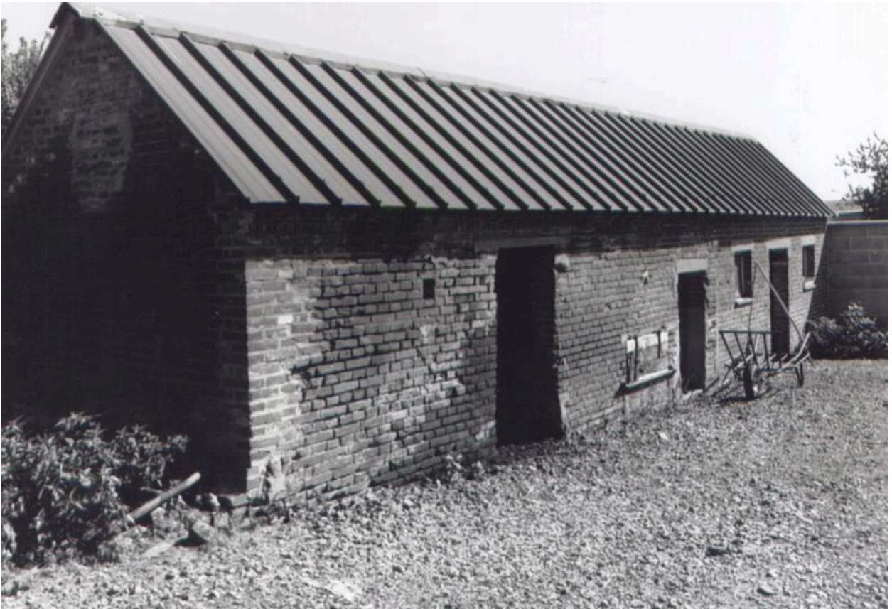
Les écuries et les étables de la briqueterie.
