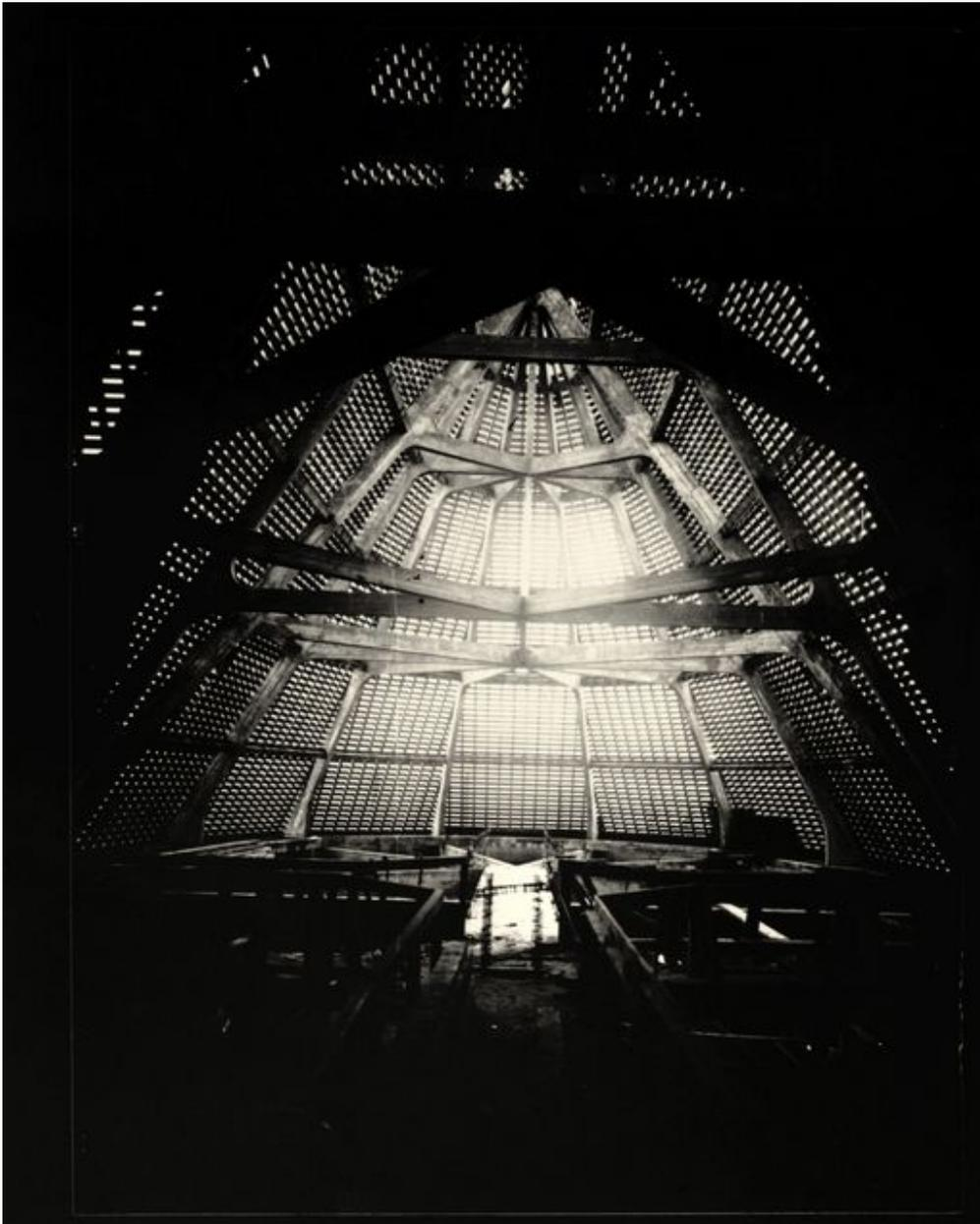
Vue intérieure de la charpente de l'abside, pendant la pose de la couverture (photographie des années trente).
