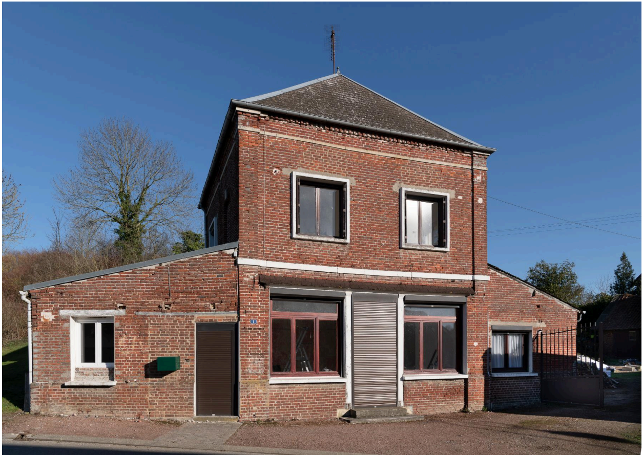
Ancien café, route de Froissy, vue prise depuis l'ouest.
