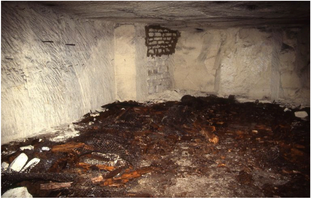
Vue intérieure de la carrière.
