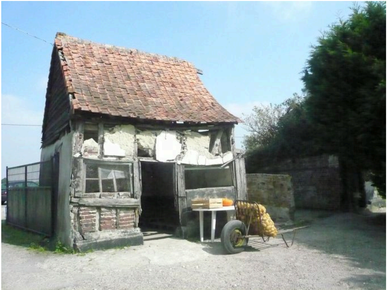
Vue sur la laiterie au nord-est de la cour.
