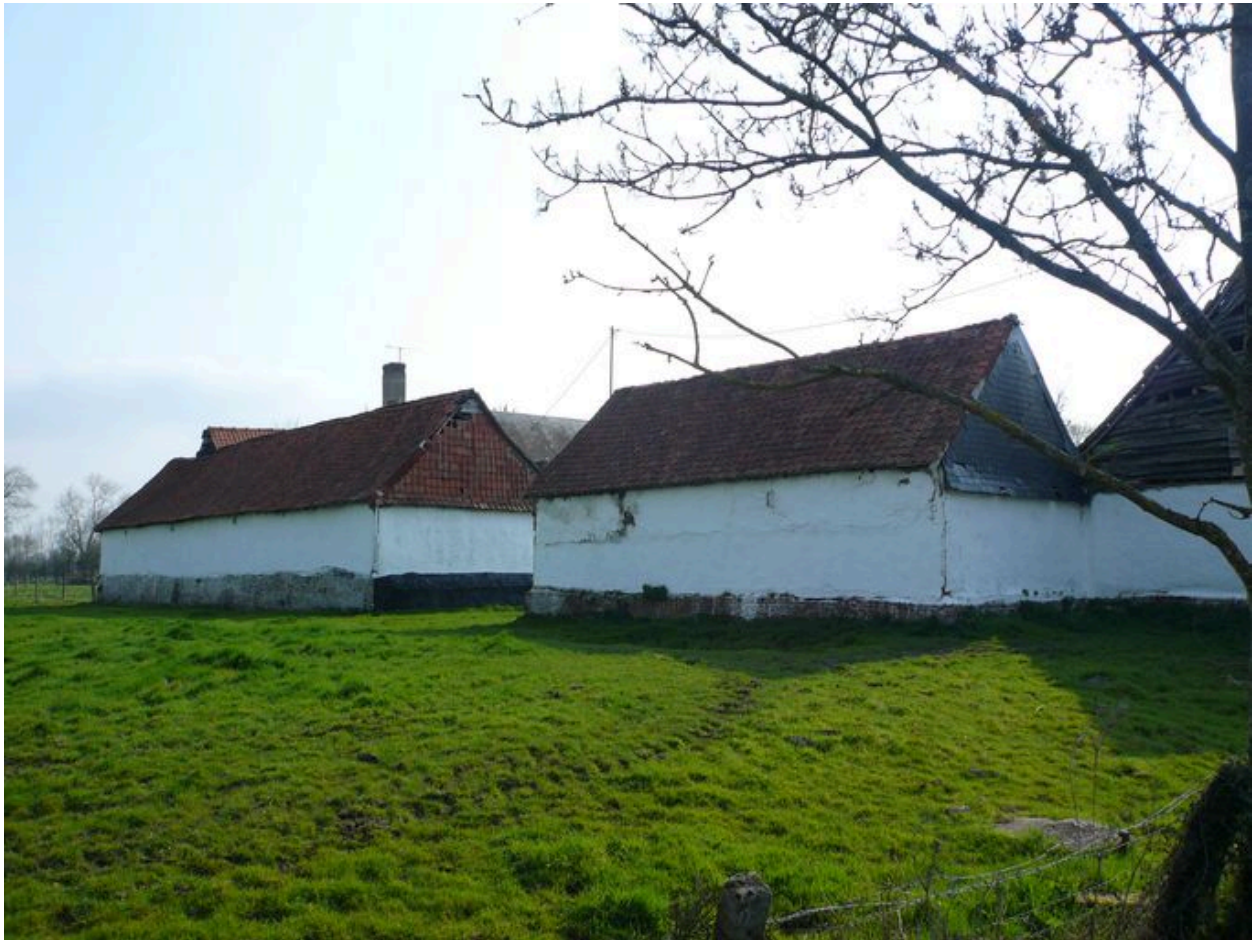
Vue postérieure de ces étables depuis la pâture au nord.
