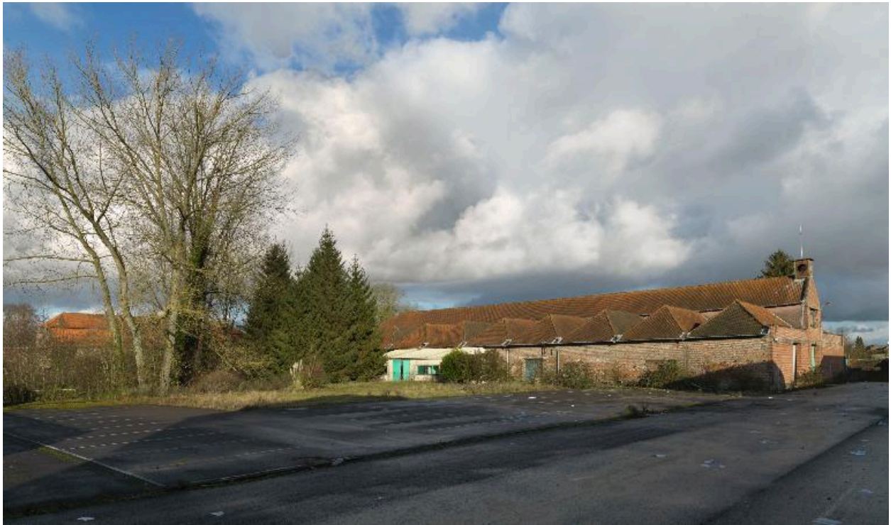
Vue d'ensemble des seconds entrepôts à jute, depuis l'ouest.
