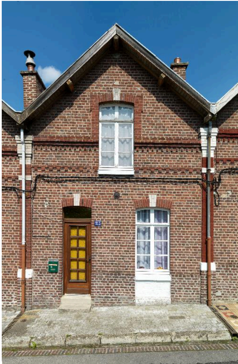
Façade sur rue du logement 315 rue Victor Hugo.
