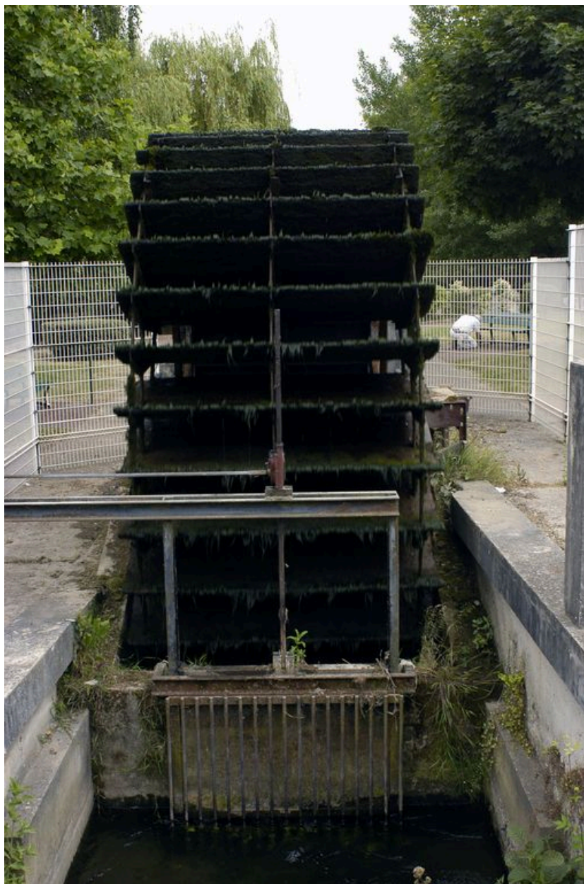
La roue hydraulique verticale remontée sur le site, vue de face.
