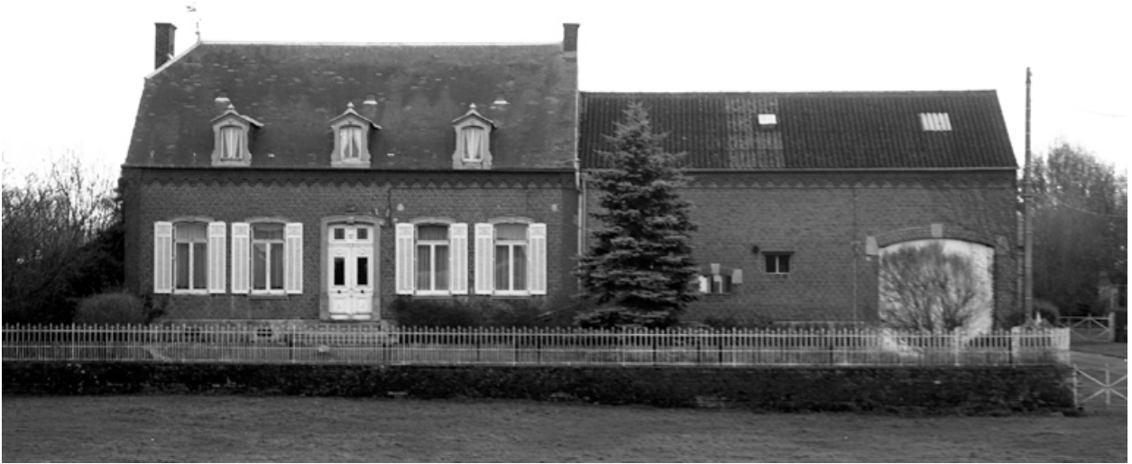
Façade du logis, de l'étable et de la grange.
