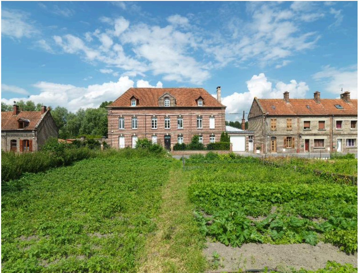
Vue d'ensemble sur rue de la crèche des Moulins-Bleus au milieu des logements.
