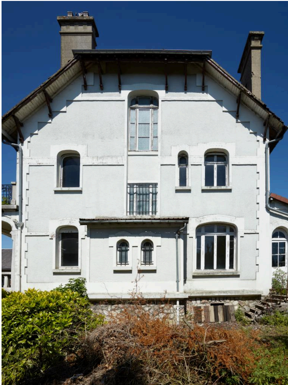
Vue de la façade latérale droite.
