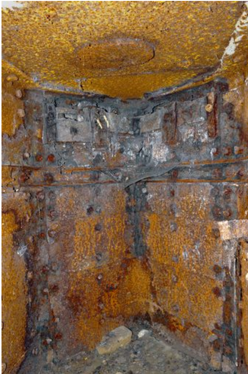
Vue intérieur de l'observatoire cuirassé est (au grand angulaire)
