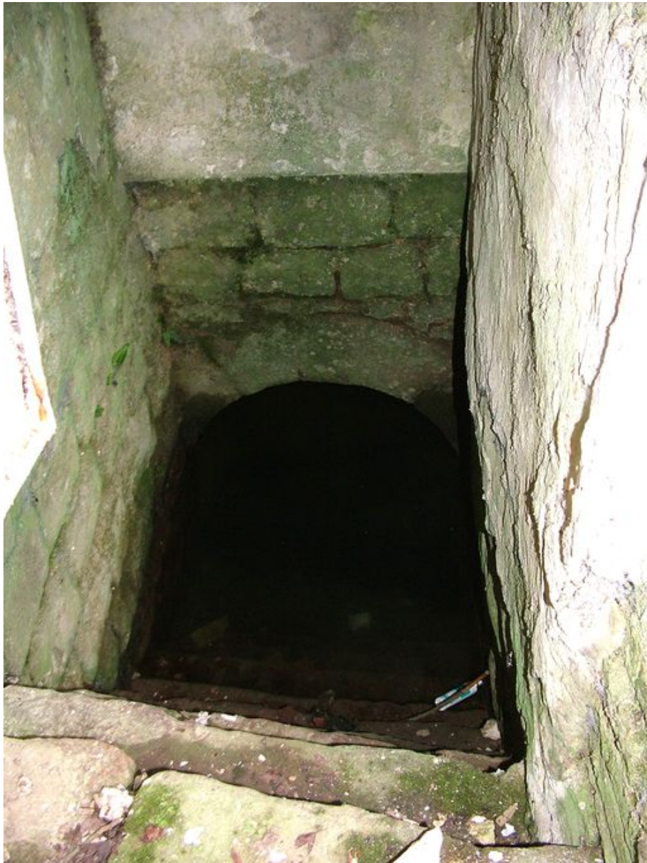
Escalier d'accès à la fontaine.
