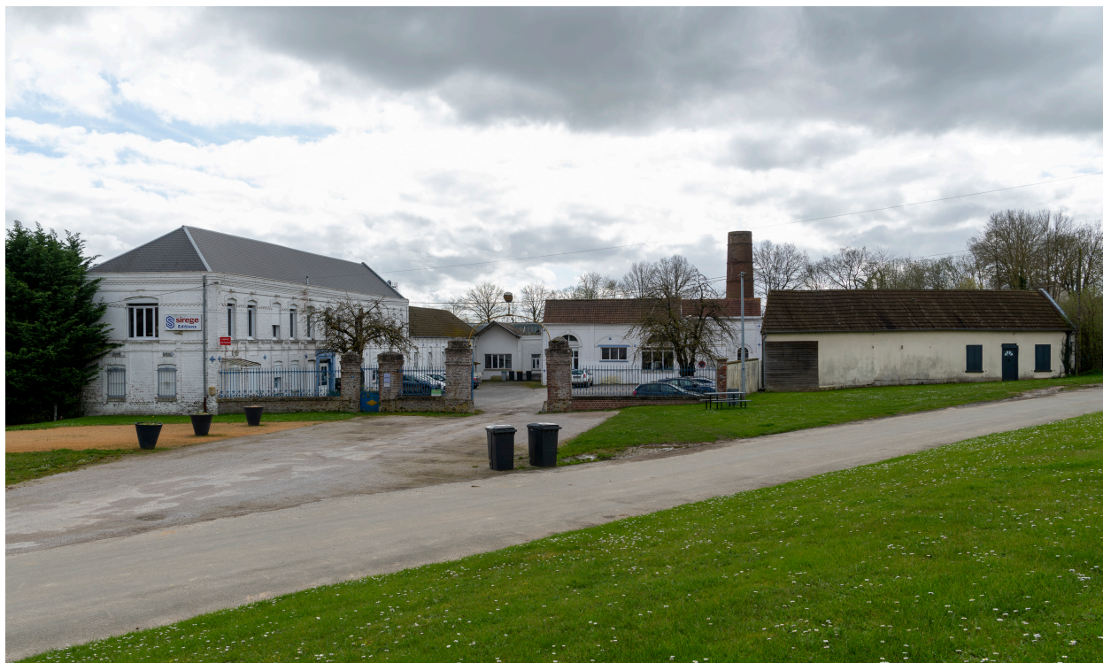
Vue générale de l'usine depuis le nord.
