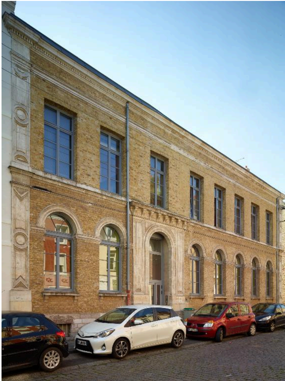
Vue de trois quart de la façade, vers le sud ouest.
