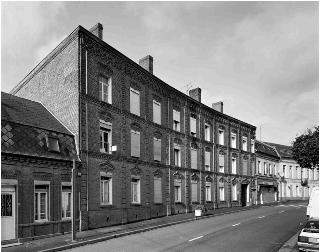
Vue de la façade sur rue.
