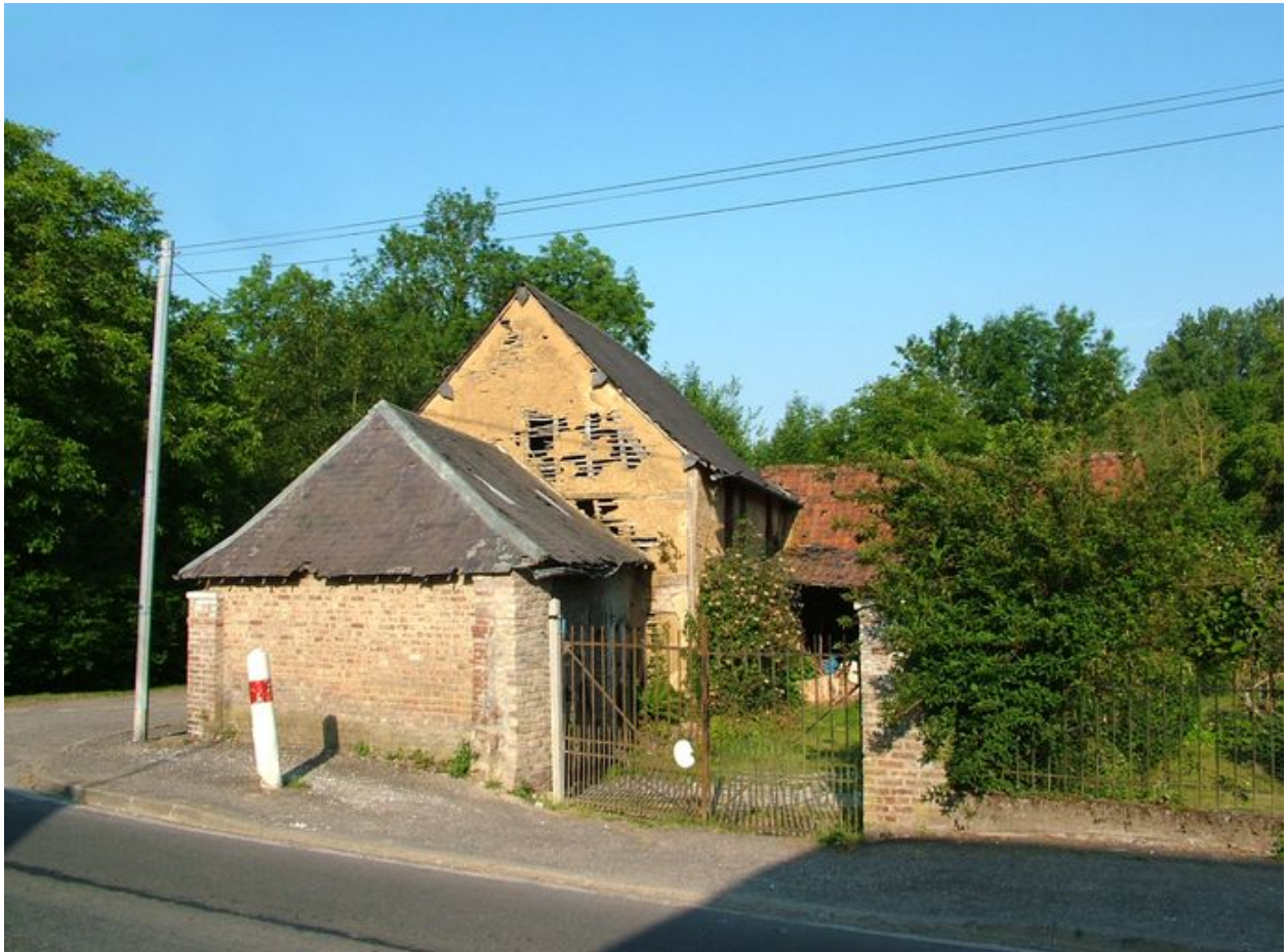
Vue partielle des bâtiments d'exploitation depuis la rue.
