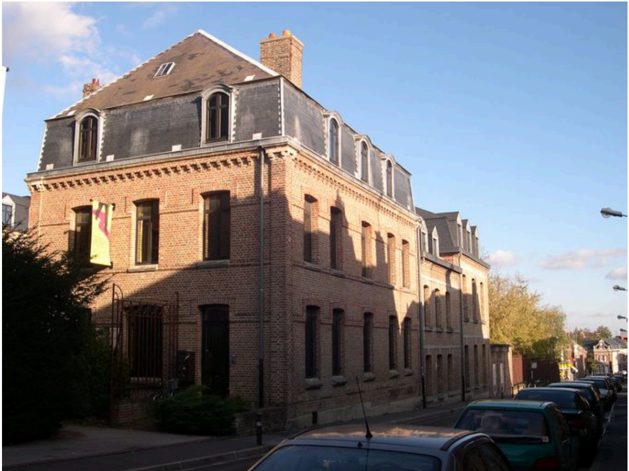
Vue des bâtiments bordant la rue Pointin.
