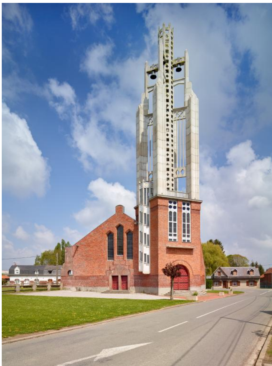
Vue vers le nord-est.
