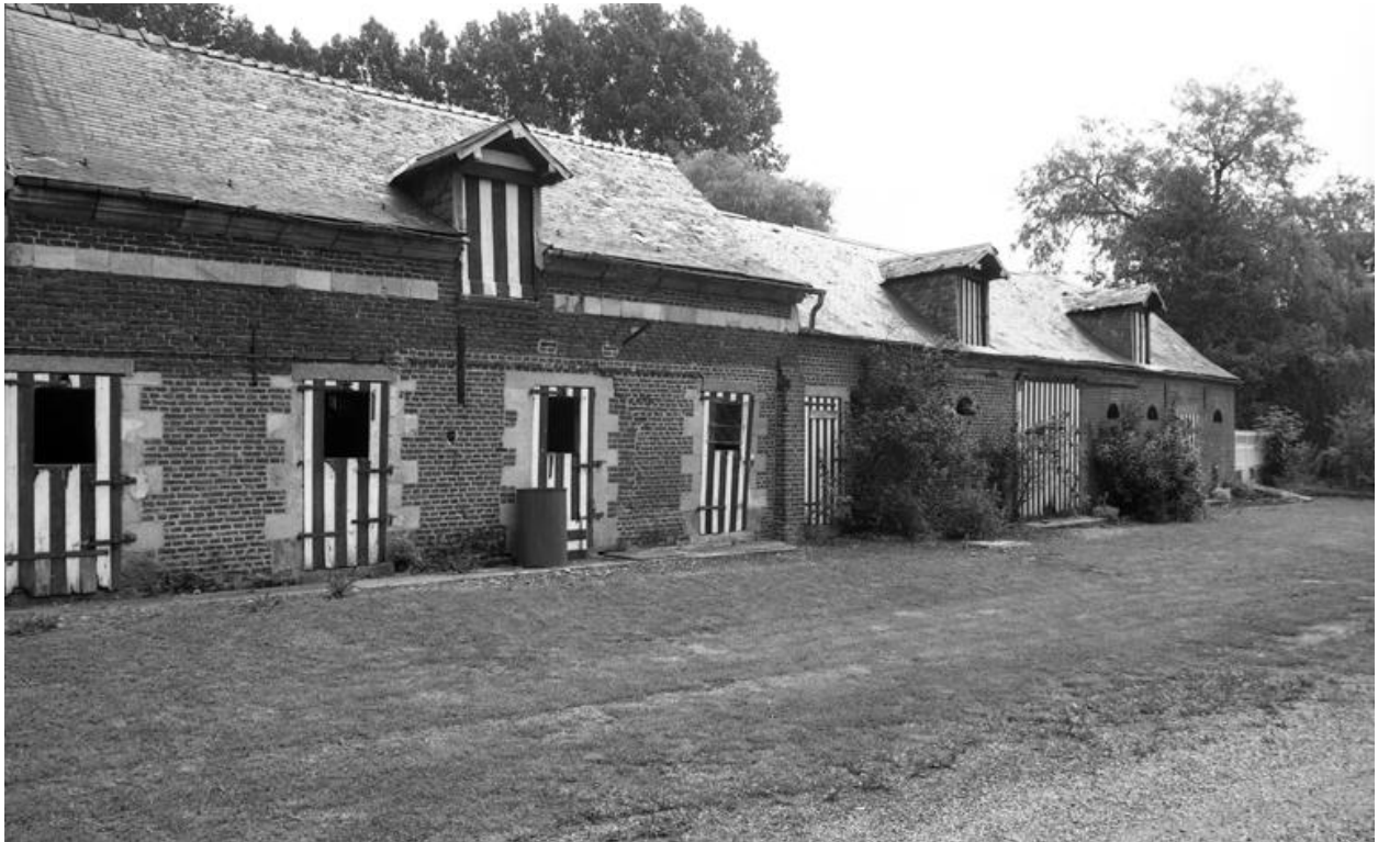
Vue de l'élévation sur cour des étables.
