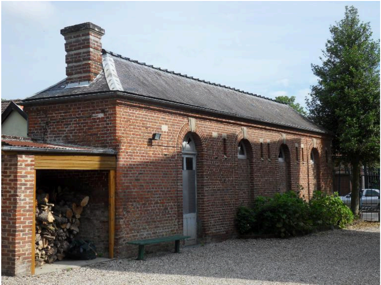
La remise de la pompe à incendie.
