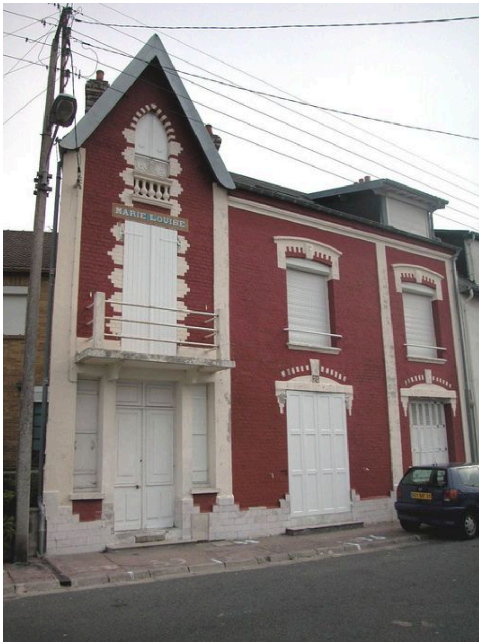
Vue d'ensemble depuis la rue du Capitaine-Guy-Dath.
