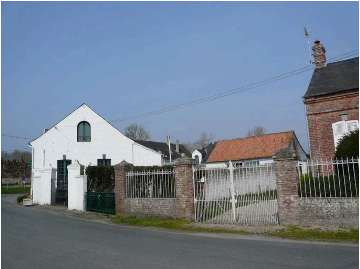
Vue des bâtiments depuis l'est.
