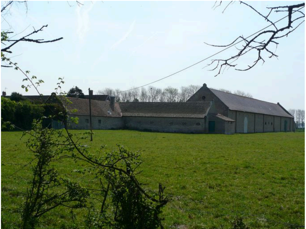
Vue postérieure de la grange et des étables à l'ouest.
