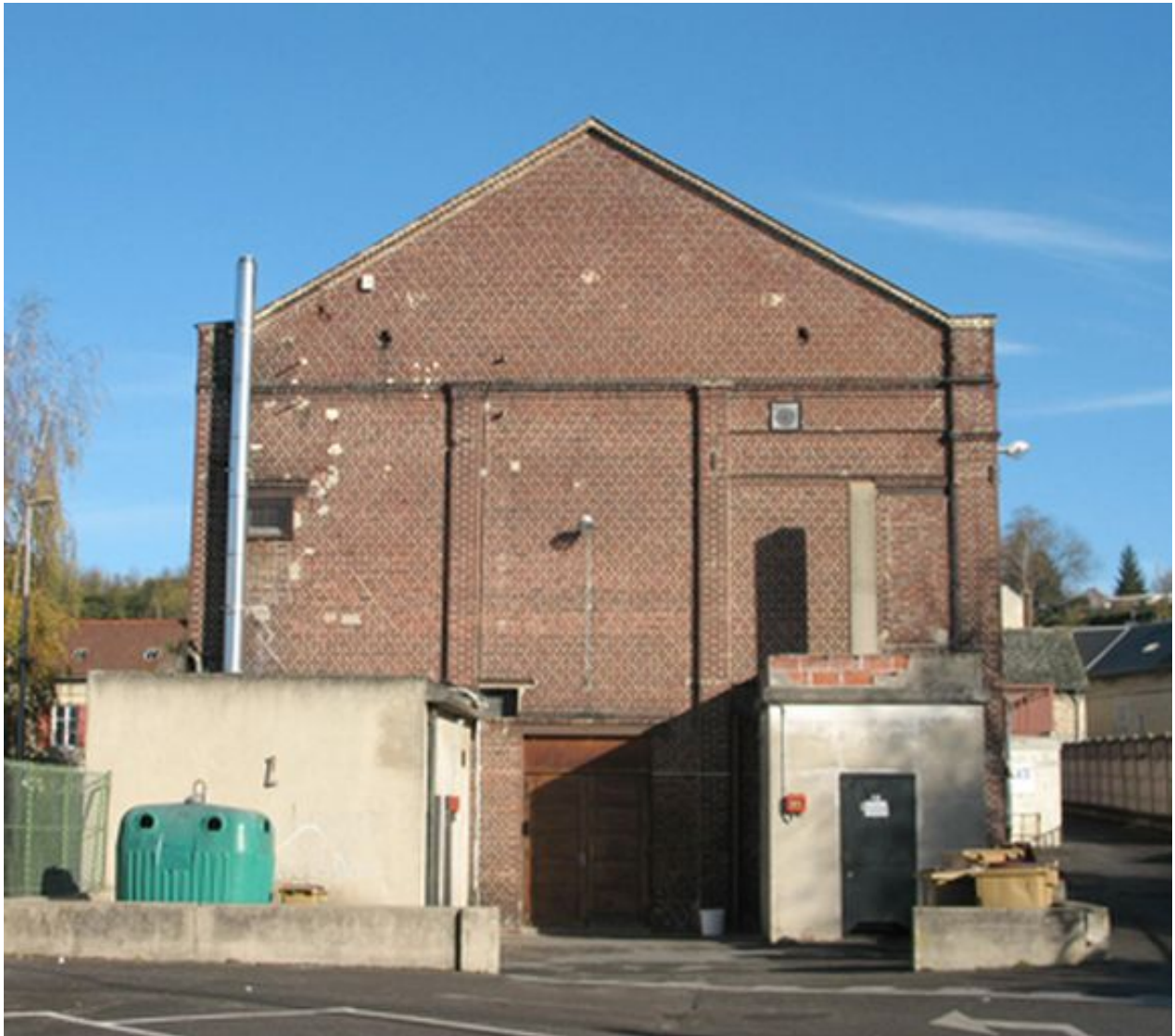
Façade sud de la salle des fêtes.
