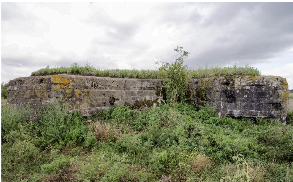
Vue générale vers l'est
