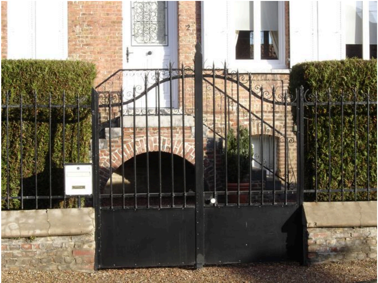
Vue détaillée du perron abritant l'entrée de la cave.
