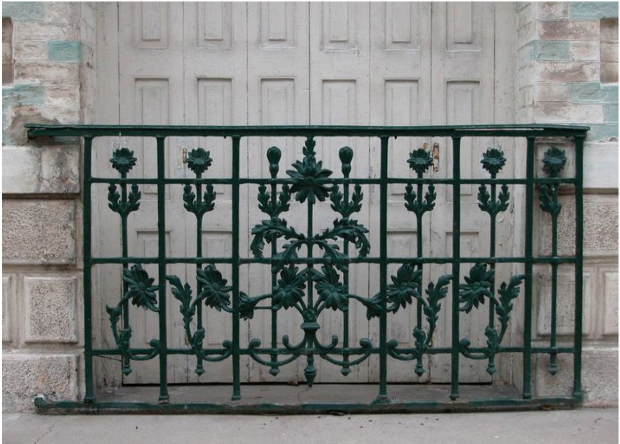
Vue du garde-corps en fonte de la baie du rez-de-chaussée.
