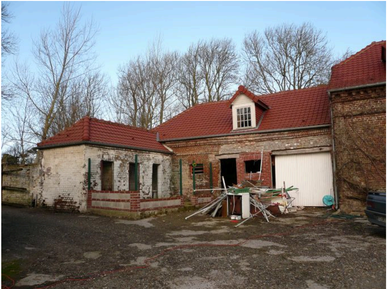
Vue détaillée du poulaillier accolé au logis à l'ouest.
