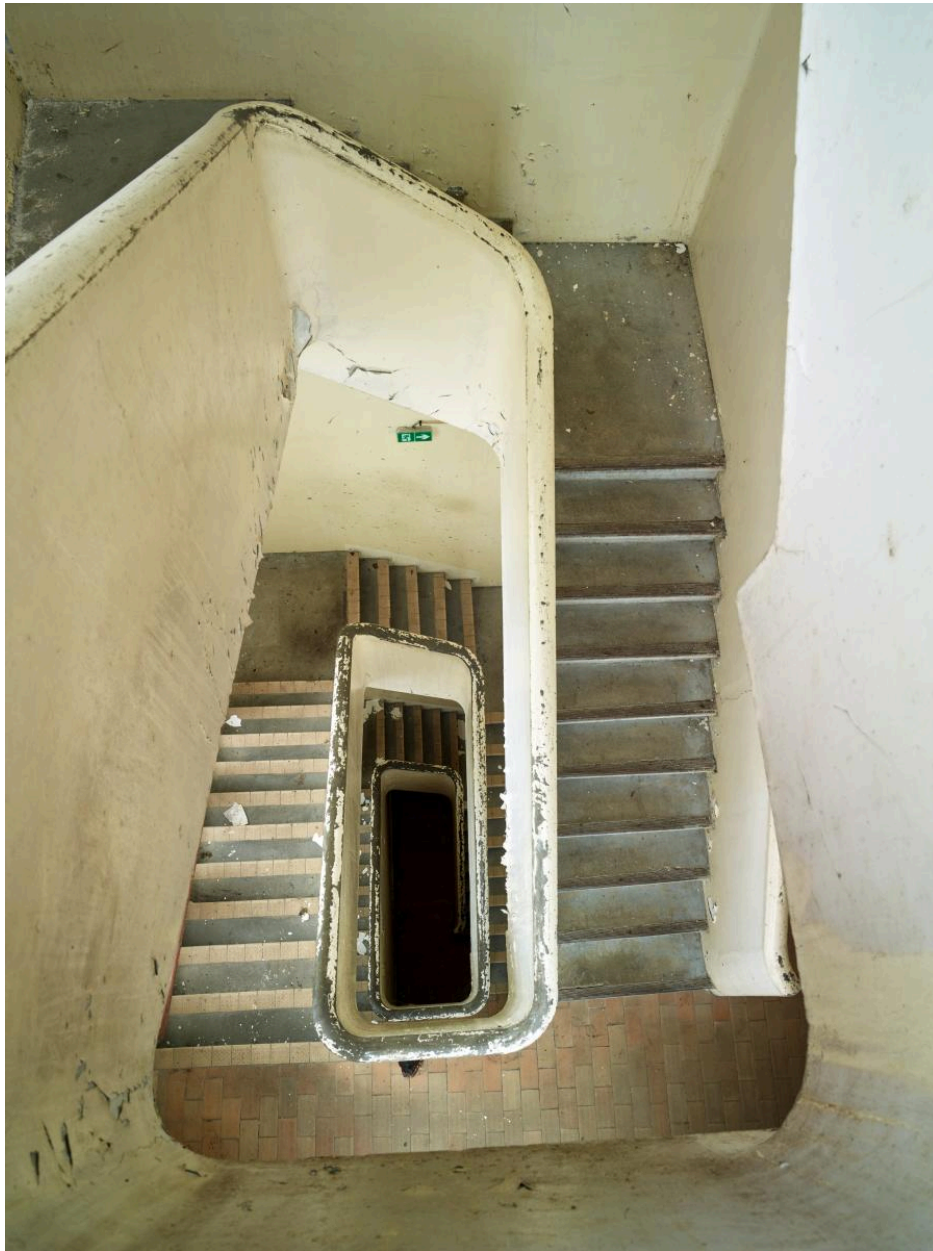
Vue intérieure de la tour d'angle de l'atelier de fabrication (H). Vue plongeante de la cage d'escalier depuis le dernier palier.
