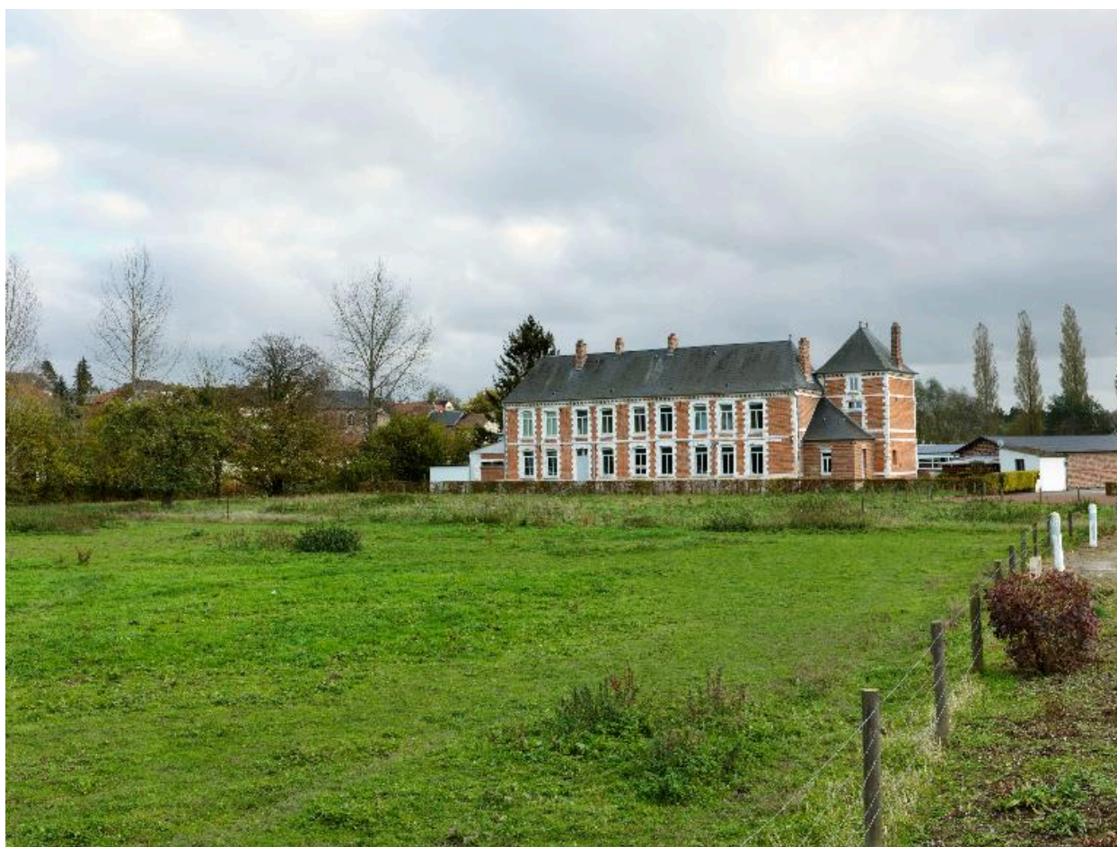
Vue de situation, depuis le nord.
