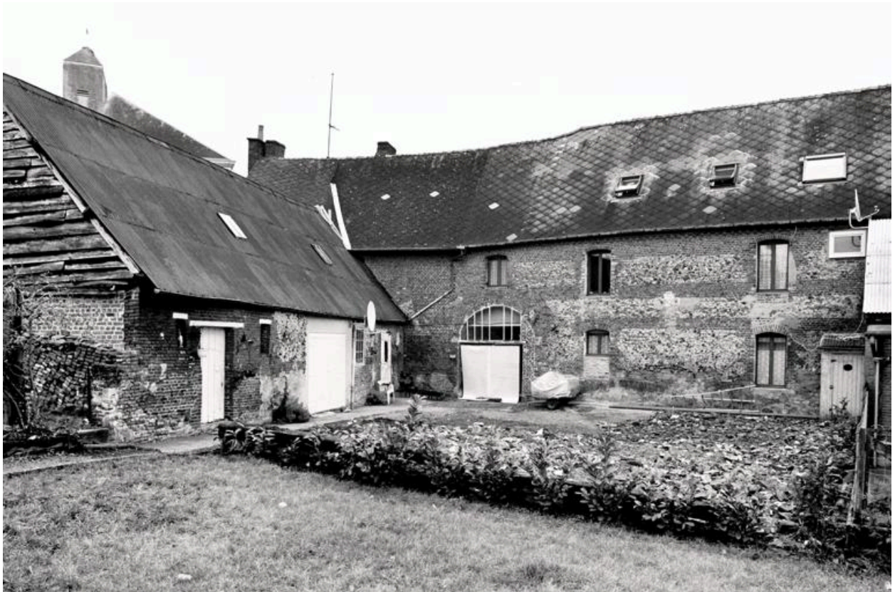
Vue de l'élévation postérieure sur la cour, construite en silex et brique.
