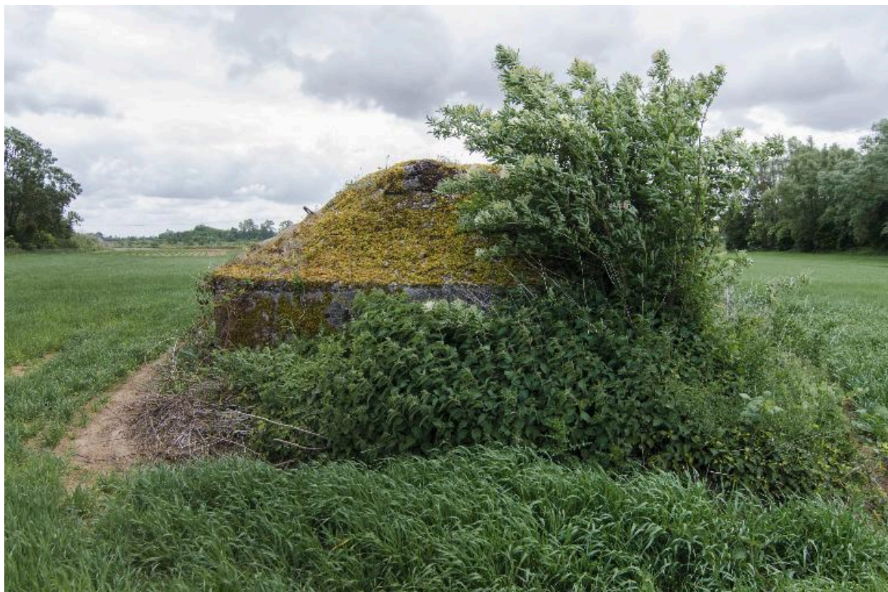
Vue générale vers le nord-ouest
