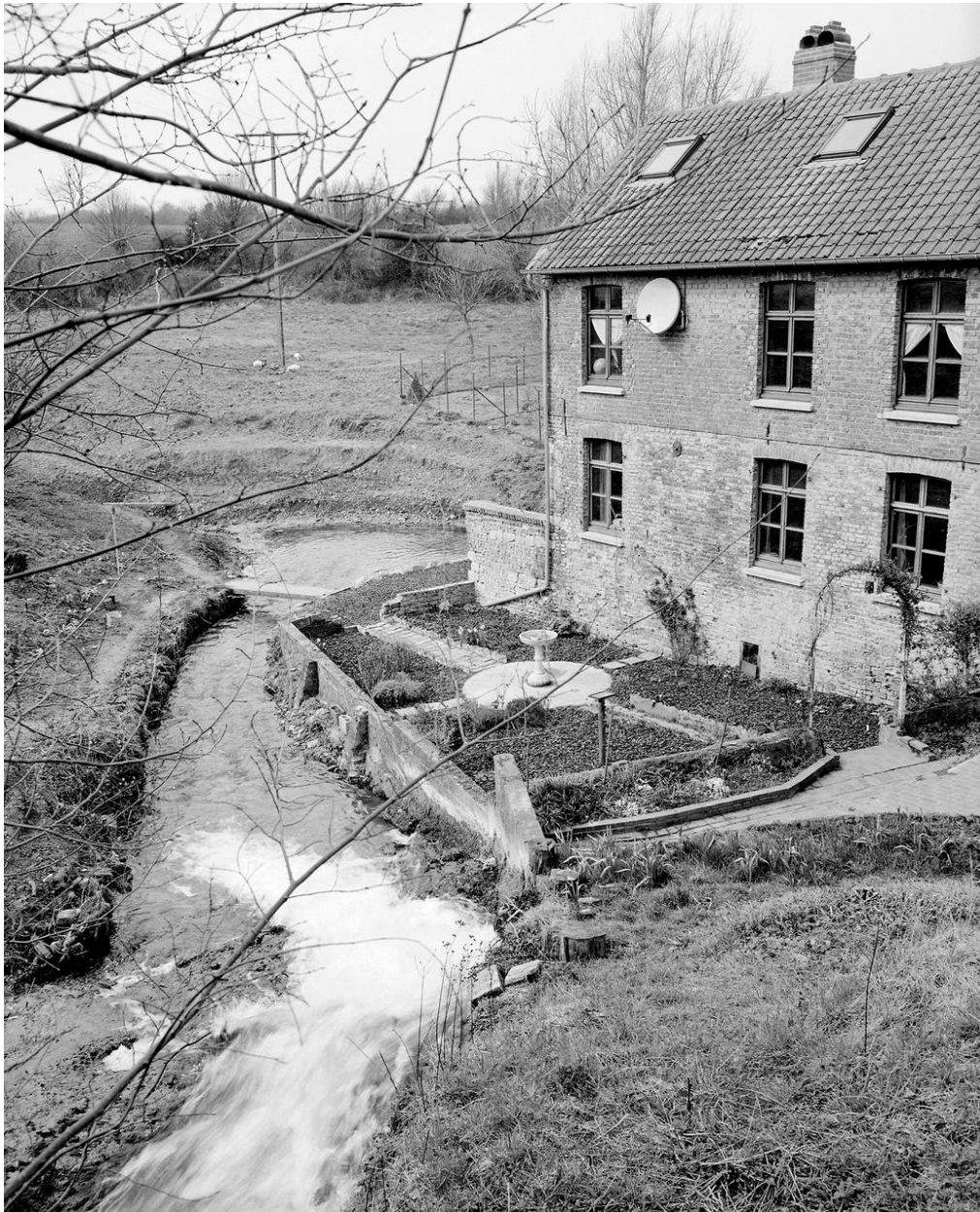
Élévation sud, chute et canal de décharge en 1993.
