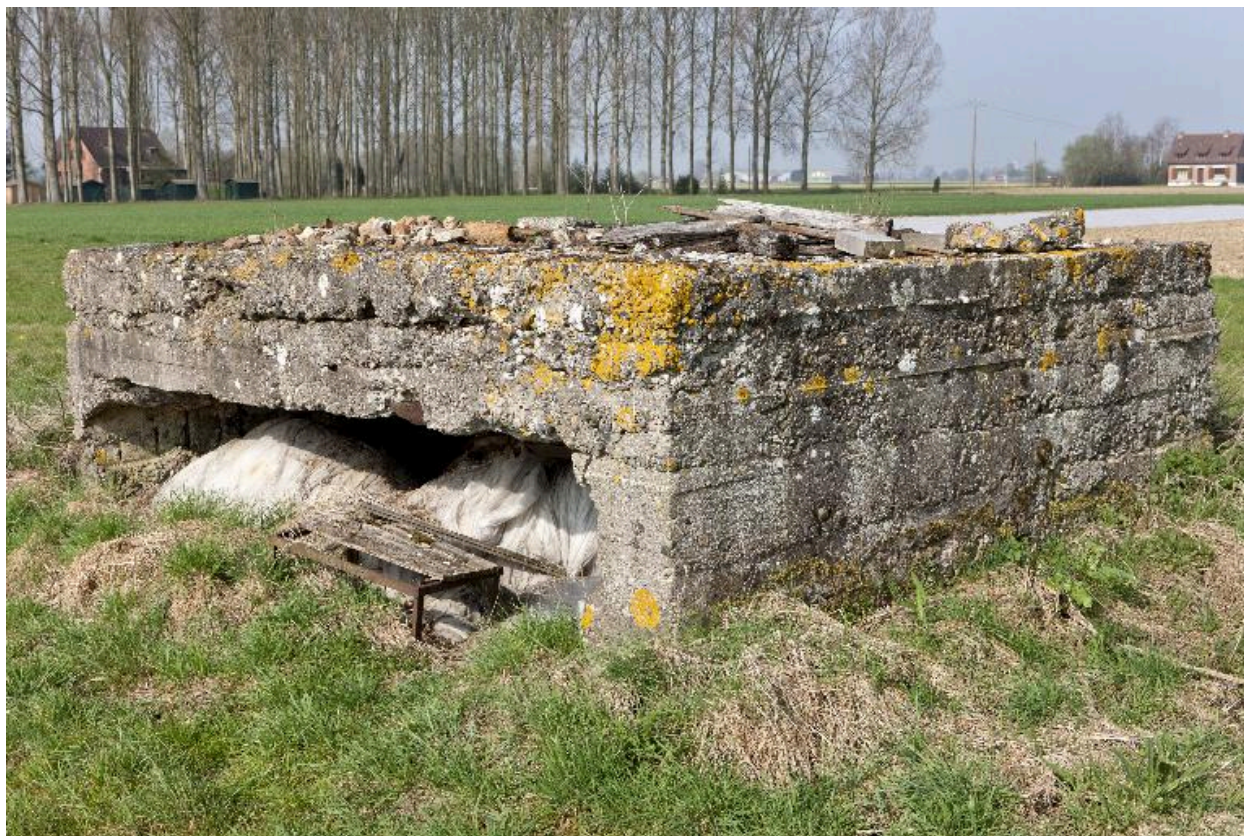
La casemate ouest, élévation sud
