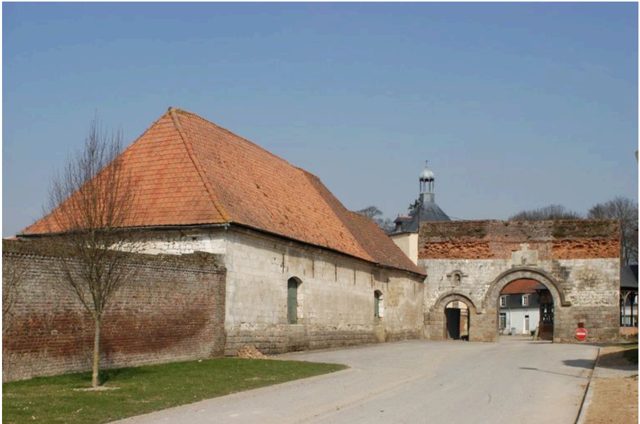
Grange et cellier, vue depuis le sud-est.
