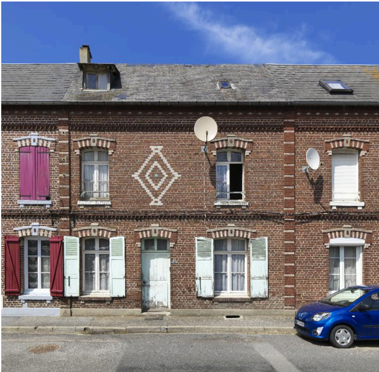
Détail du logement n° 63.
