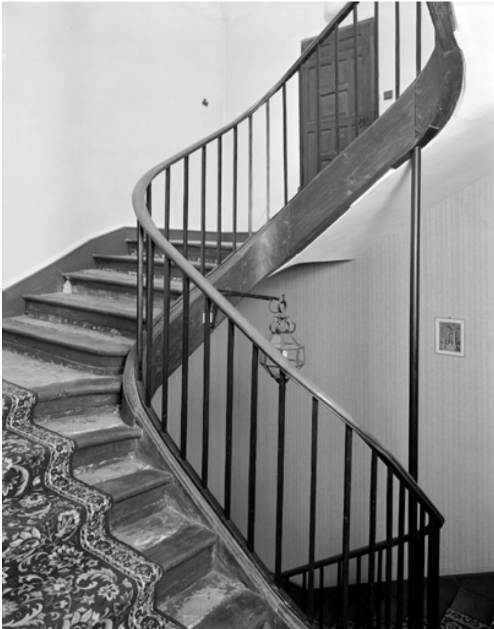
La cage d'escalier.
