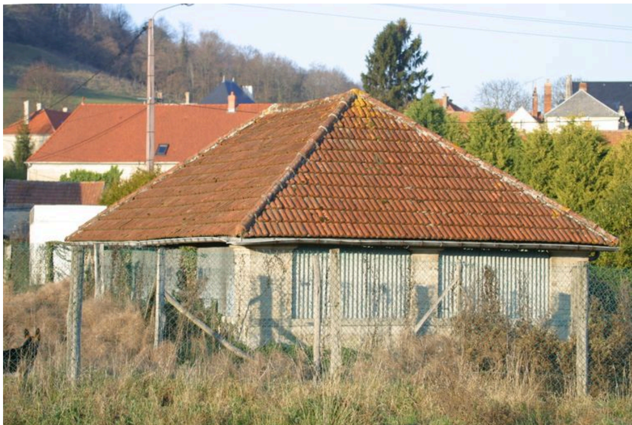
Vue du lavoir.
