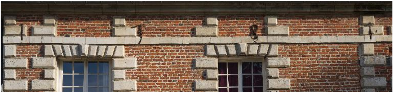
Détail des fers d'encrage de l'aile des communs formant la date de 1781.
