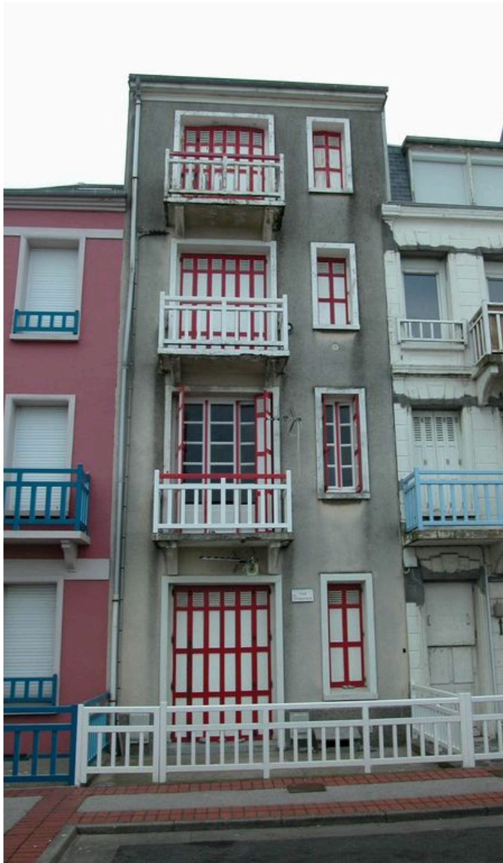
Vue d'ensemble depuis l'esplanade.
