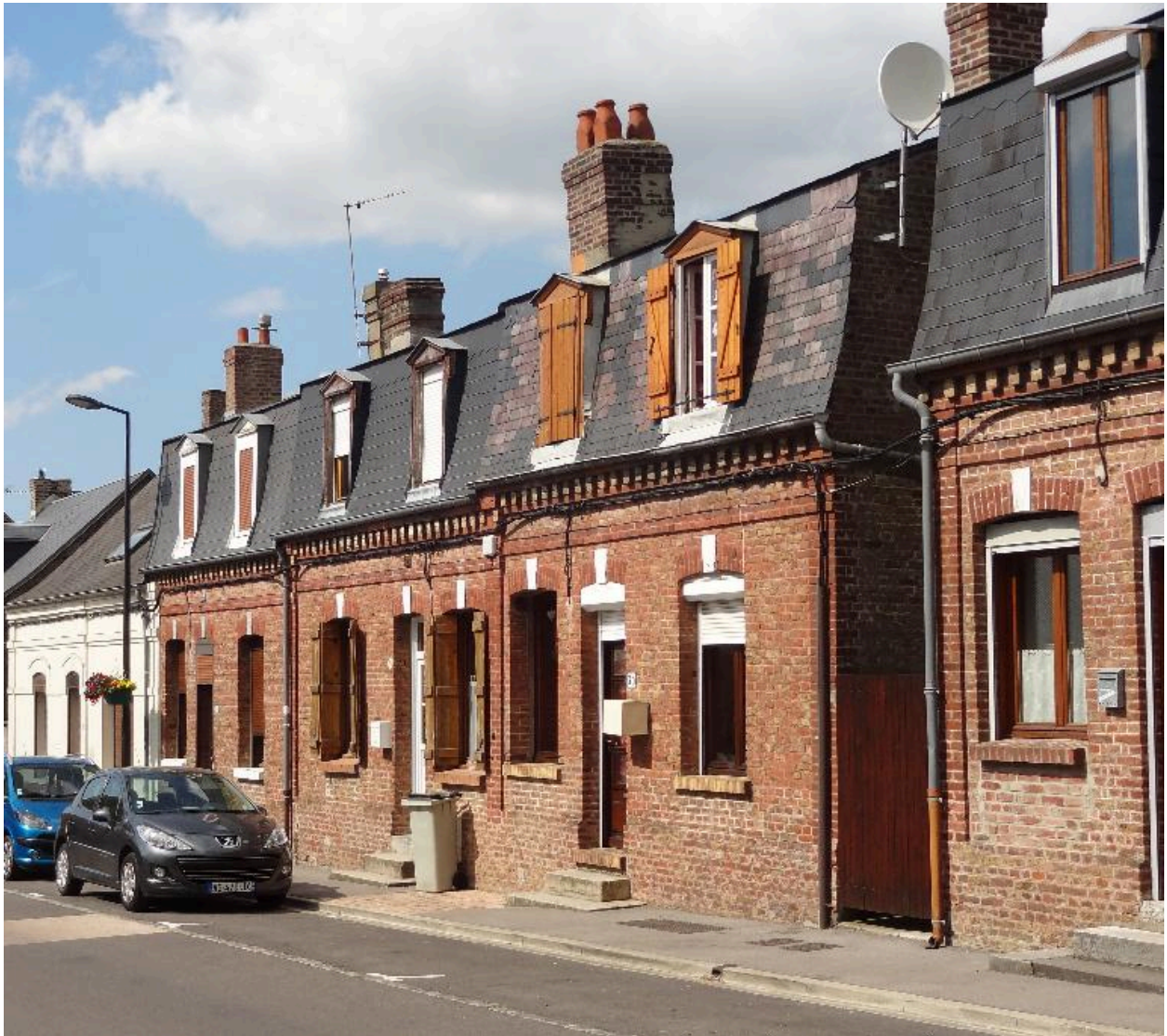
Vue des logements n°31 à 35 rue Jules-Vallès.
