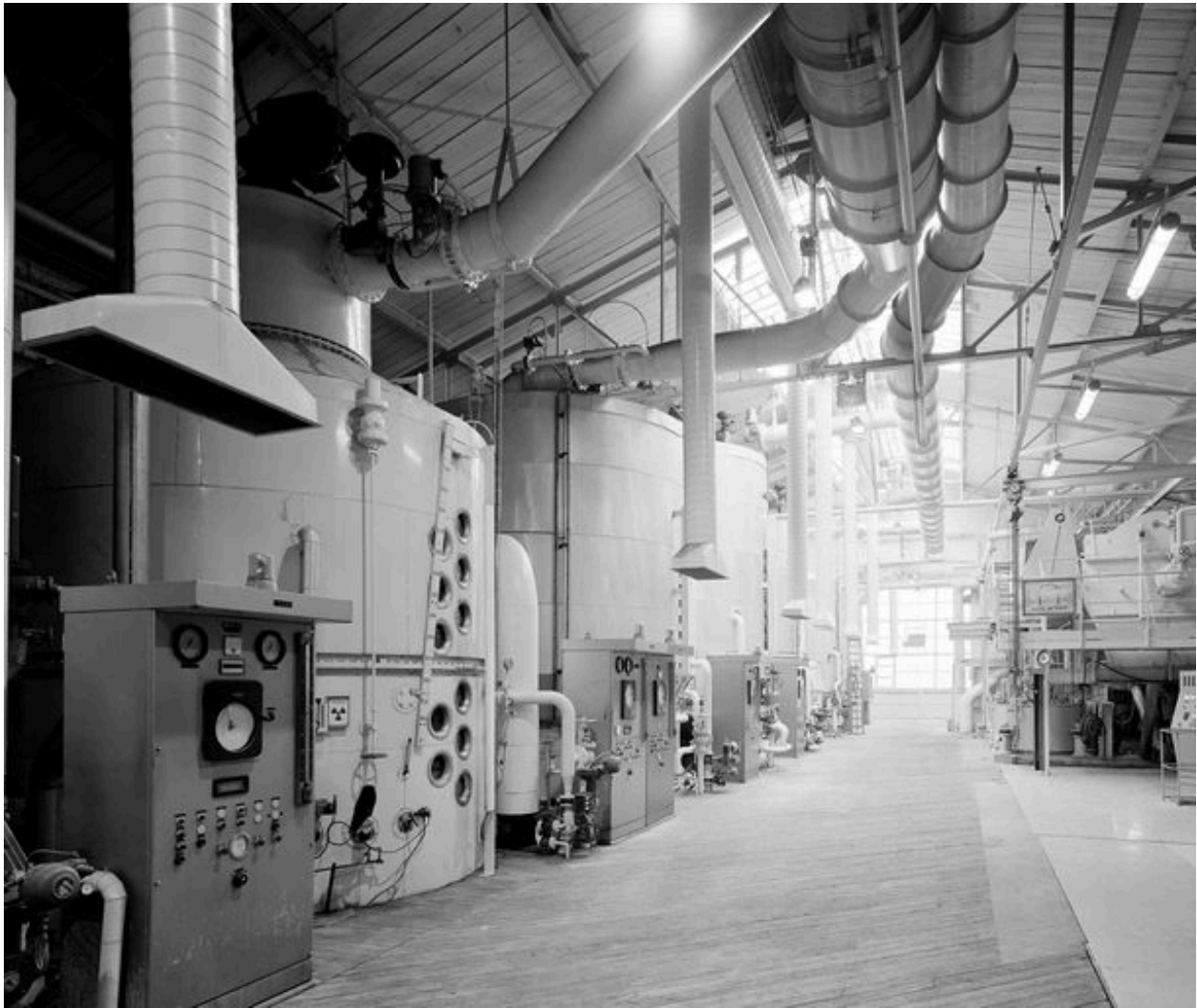
Atelier de cristallisation, vue intérieure.
