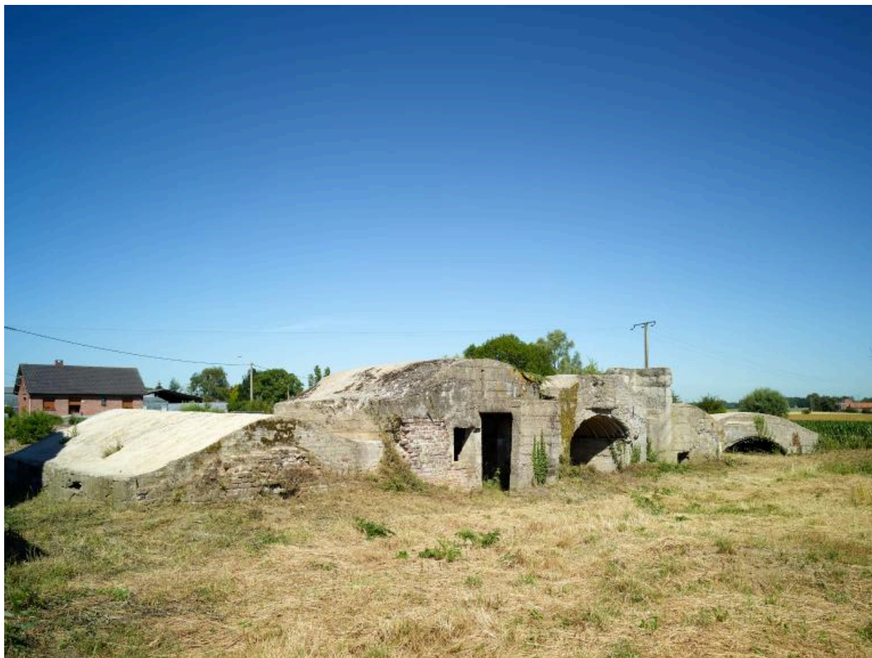
Vue intérieure des casemates b à f, vers le nord-ouest
