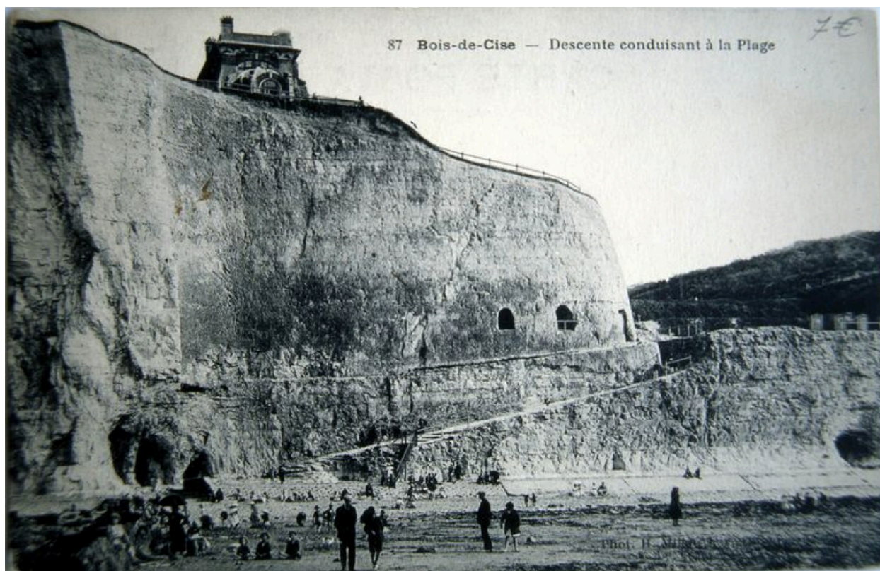
Le front de falaise et la rampe d'accès creusée dans le roc, carte postale, 1er quart 20e siècle (coll. part.).
