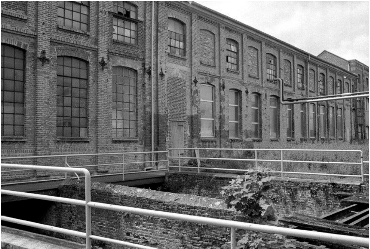
Bâtiment d'eau et atelier de fabrication.
