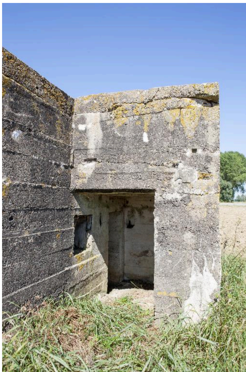
Vue vers le nord. Entrée pare-souffle
