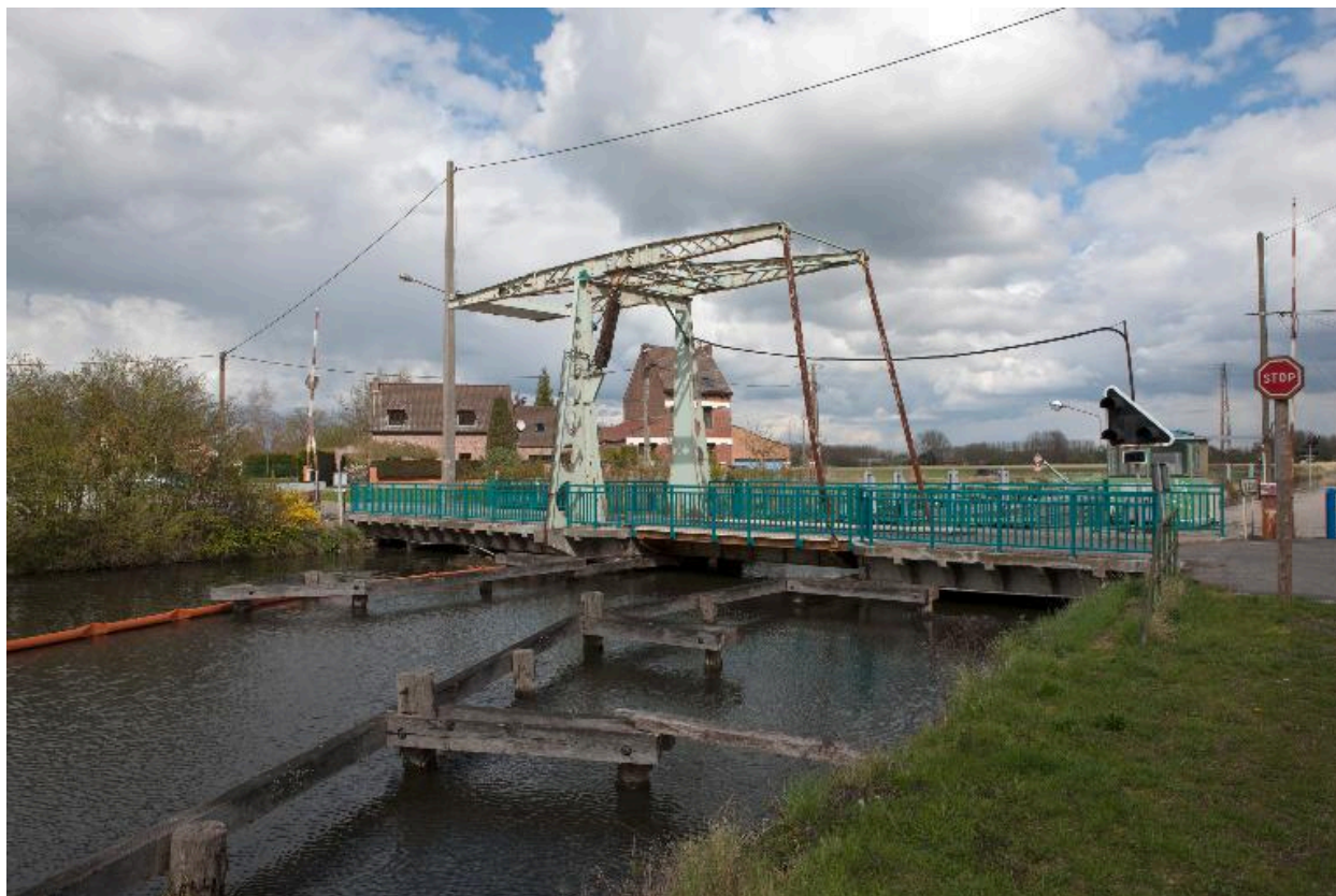
Le pont mobile sur la Scarpe.
